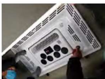
4. Закрепить кондиционер крепёжным швеллером, закрыть облицовочной рамкой
