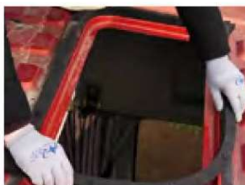
2. Прикрепить уплотнитель по контуру люка
